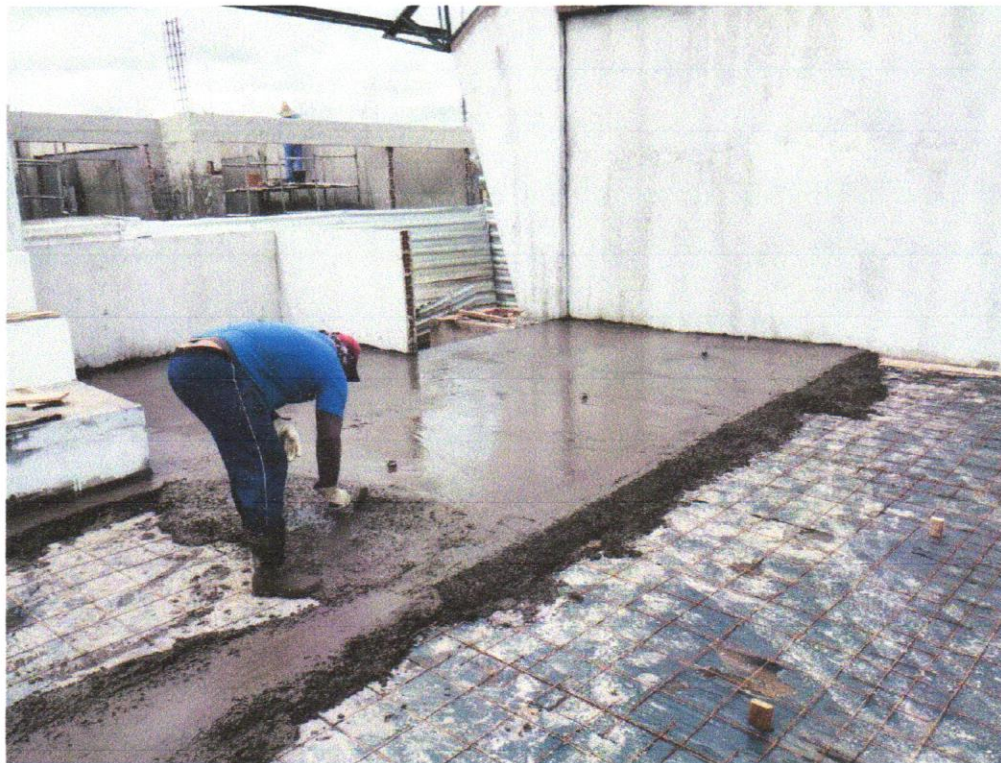
IMAGEM 07 - Piso alta resistencia, cor cinza, e=10mm, aplicado com juntas, polido até o esmeril 400 e encerado, exclusive argamassa de regularização
