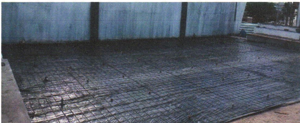
IMAGEM 06 - Piso alta resistencia, cor cinza, e=10mm, aplicado com juntas, polido até o esmeril 400 e encerado, exclusive argamassa de regularização
